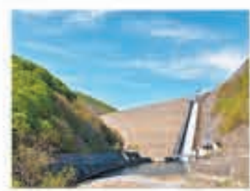
奈良俣発電所
